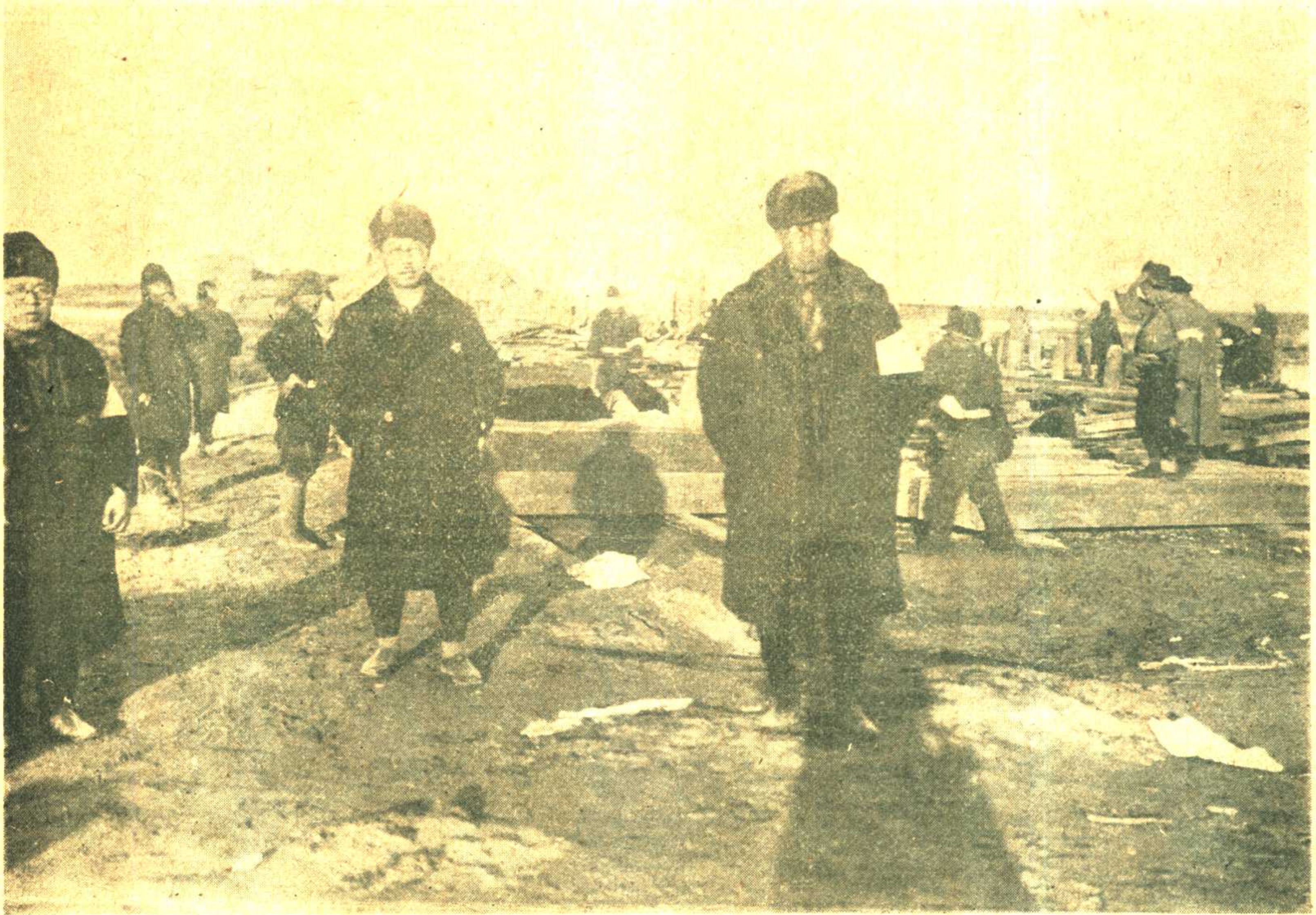
(上) 修理中之江橋第二橋梁(滿洲日報社攝影)
