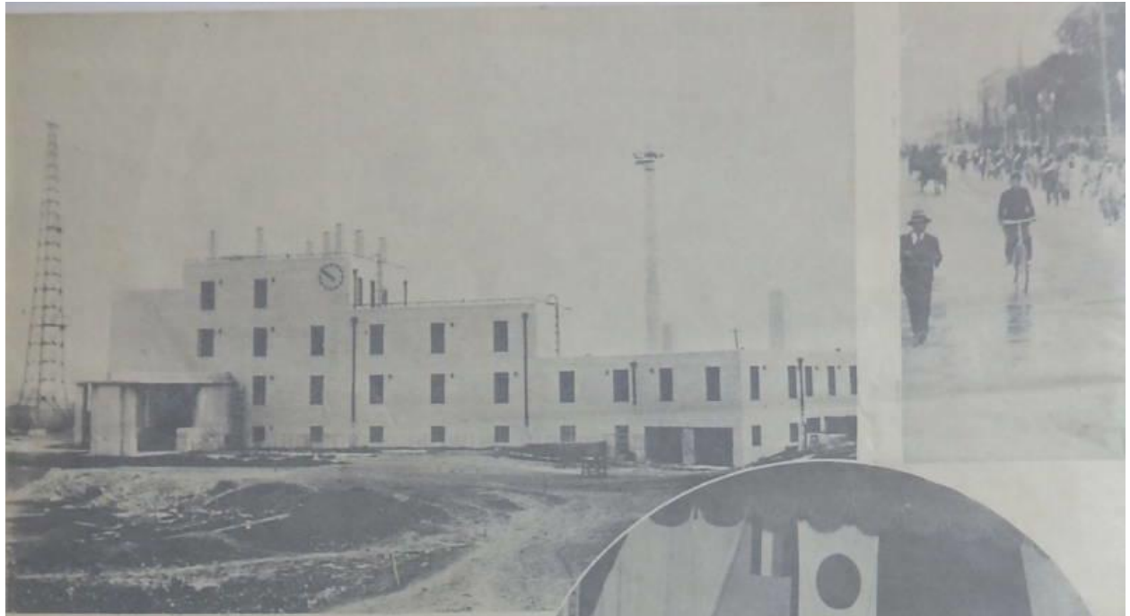
於俄且之國萬七十當投以國西滿 觀央中國洲滿之中設建備府京新 日不轉轉工之體大其舍館新蓋衆 云矣竣告行即
