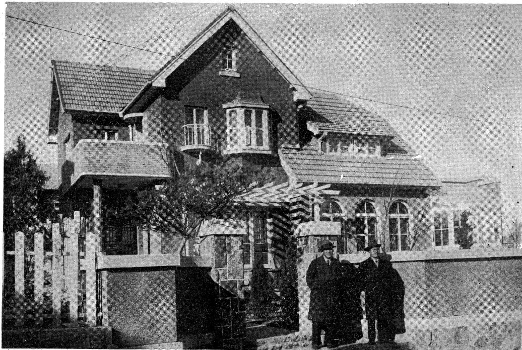
水明莊 K氏邸 外觀 設計 宗像建築事務所 施工 河野工務所
