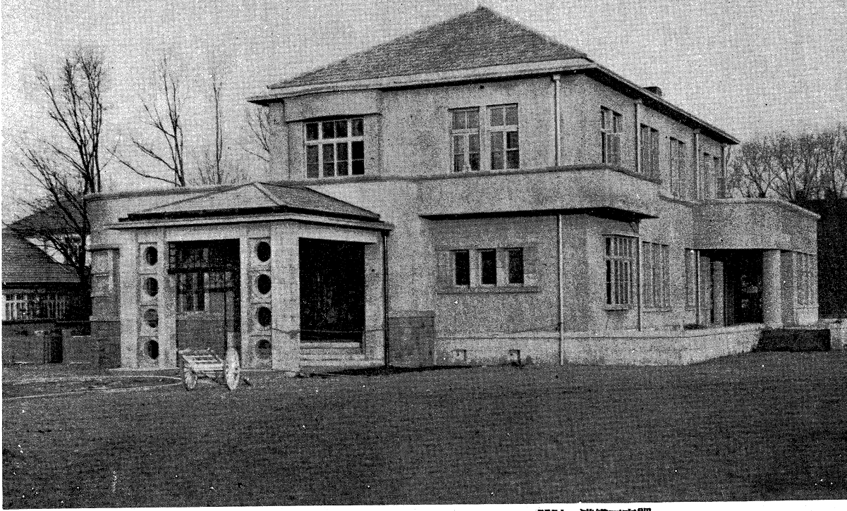
滿鐵理事公館 設計 滿鐵工事課 施工 蔦井組
