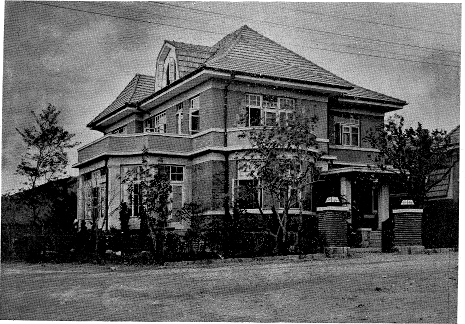
外観 腰粗石獨逸積、壁洞蛇腹下フェースブリック積、同上リソイド塗、屋根セメントモルタル瓦葺、サンルーム・ポーチ柱擬石塗、門礫滓カトブリック積、窓面積の廣いと欄間構造に博士の主張が現はれてゐる。
