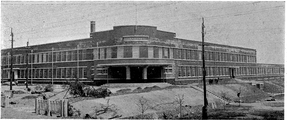
全 景 (玄関正面)
